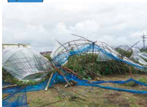
令和3年8月9日の台風9号で被害を受けたビニールハウス(出雲市)
