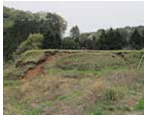
崩落した畦畔
