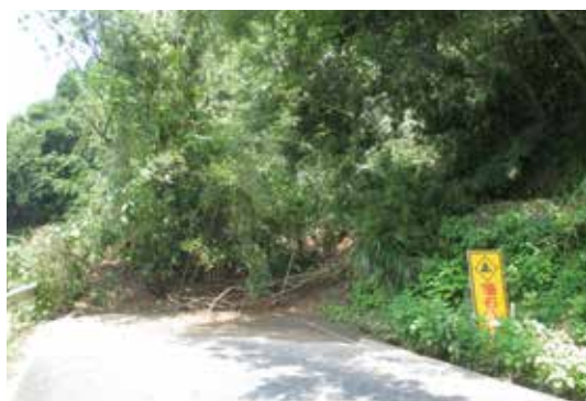
土砂崩れが道路をふさいだ（7月13日 出雲市）
