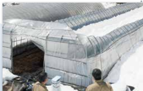
降雪により全壊したハウス
