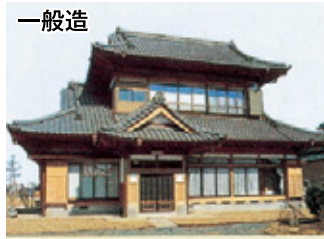
一般造 一般的な木造建物で、耐火B、Aに該当しないもの。
